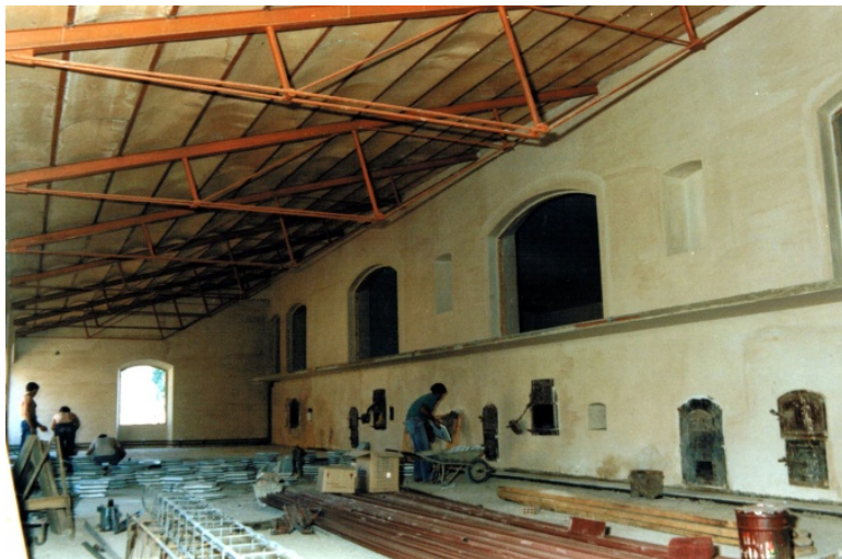
Fotografía durante la reforma
