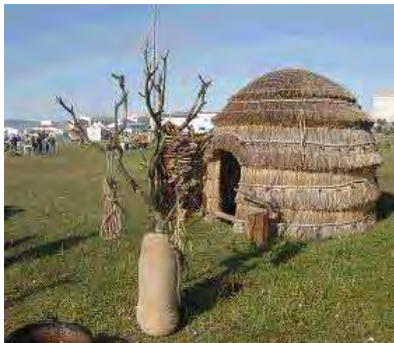
Figura 3: chozo móvil construido de bálago de centeno.
