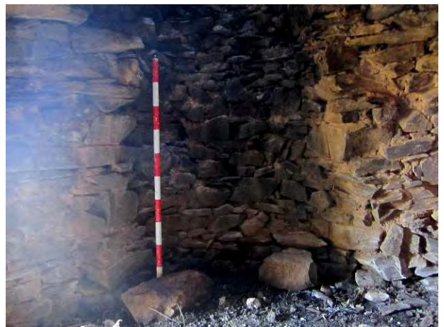
Figura 8: chimenea empotrada en la pared del chozo.
