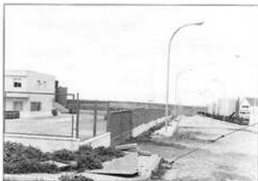
Vista parcial del polígono industrial.
