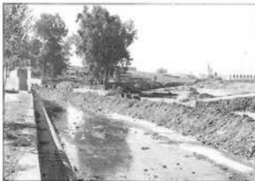
Obras para el tratamiento urbanístico del canal.
