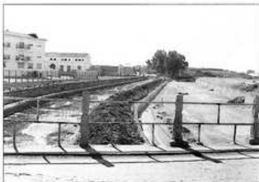
Obras Canal: Nueva canalización.
