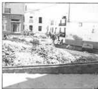
Inicios de obras para restauración de la Plaza Vieja.
