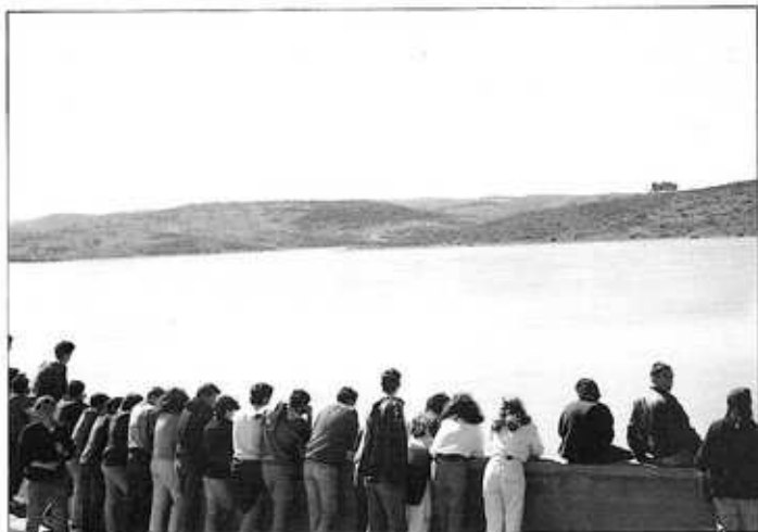
Visita de trabajo. Presa de los Molinos.
