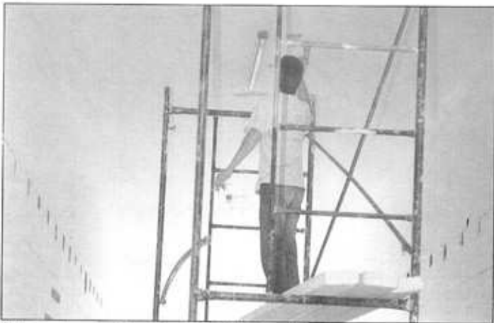
Trabajos de yesería. Centro ocupacional de minusválidos.
