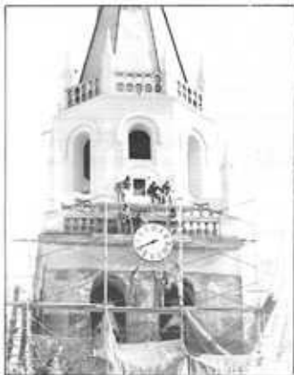
Rehabilitación Parroquia Ntra. Sra. del Valle.
