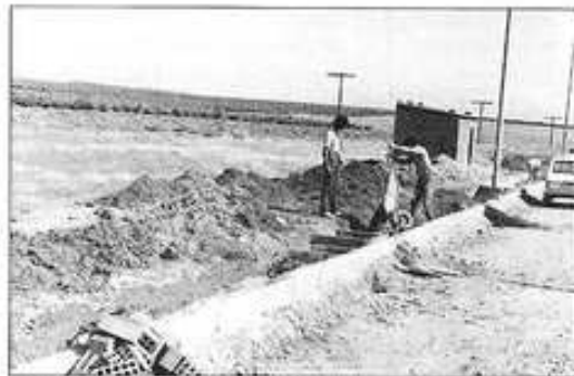
Pavimentación del polígono industrial.
