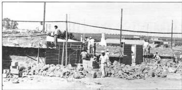
Construcción de la Caseta Municipal.
