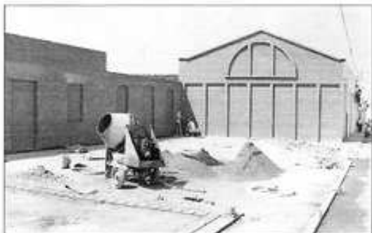
Obras de la nueva plaza en calle Grauina.
