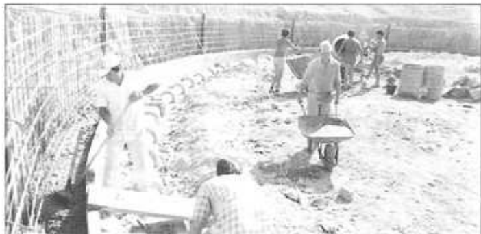
Construcción Auditorio-Plaza de Toros.
