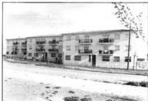
51 Viviendas: Junta de Extremadura.
