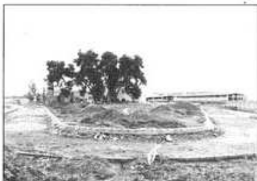
Pavimentación Polígono de la Harinera.
