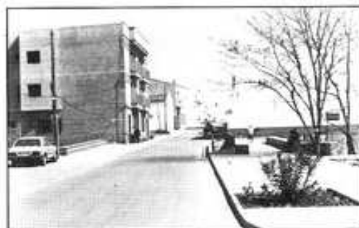
Arreglo puente y aceras Avda. Fdo. Aranguren.
